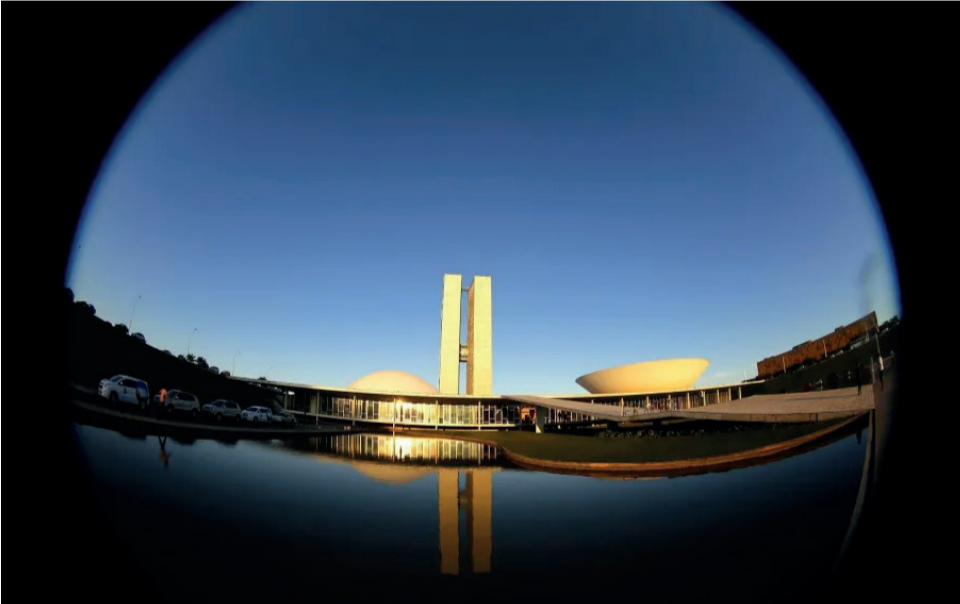
Vista do edifício do Congresso Nacional, projetado pelo arquiteto brasileiro Oscar Niemeyer • Jorge Silva/Reuters
